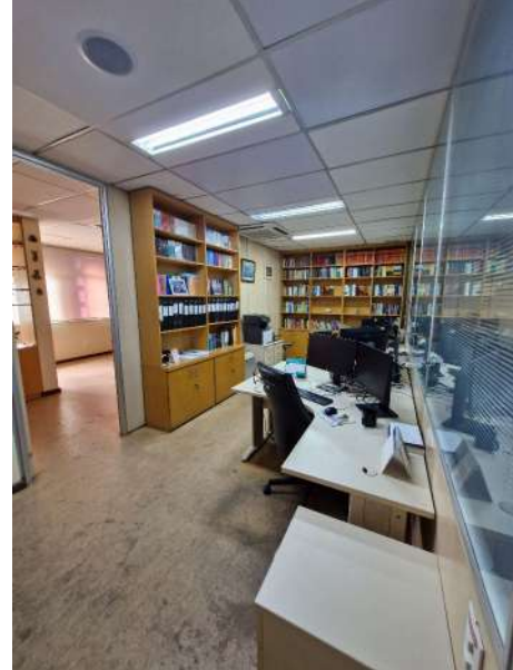
Foto 2: estrutura atual de forro com modulação de 1250 mm x 625 mm, fibra mineral e estrutura de fixação em perfil de alumínio a ser removido.
