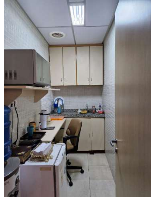
Foto 6: condições atuais do piso cerâmico da copa que será mantido, porém com aplicação de massa niveladora para receber o piso vinílico.
