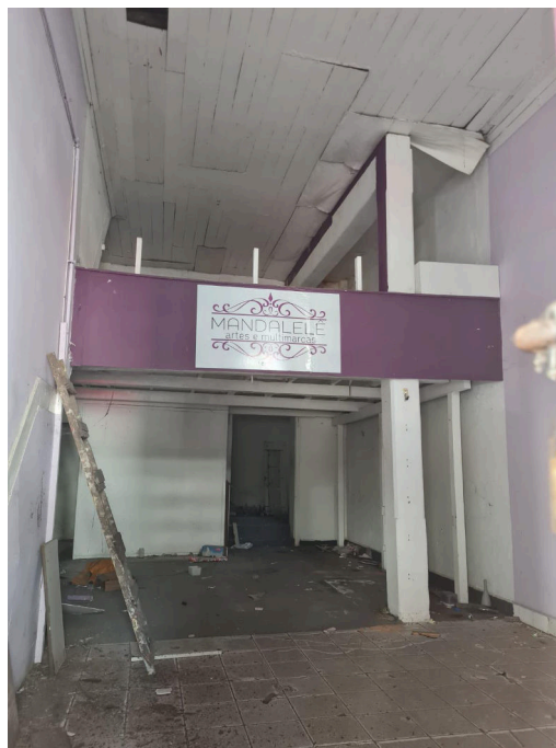
Foto 6: situação geral do imóvel nos baixos
