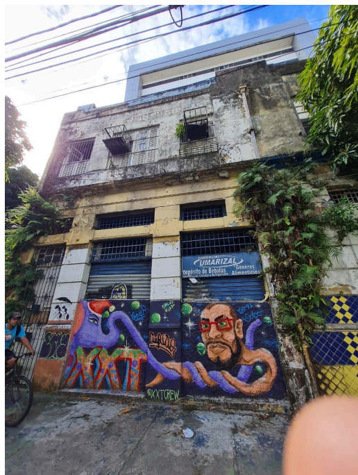
Foto 7: fachada, ao fundo o anexo V
